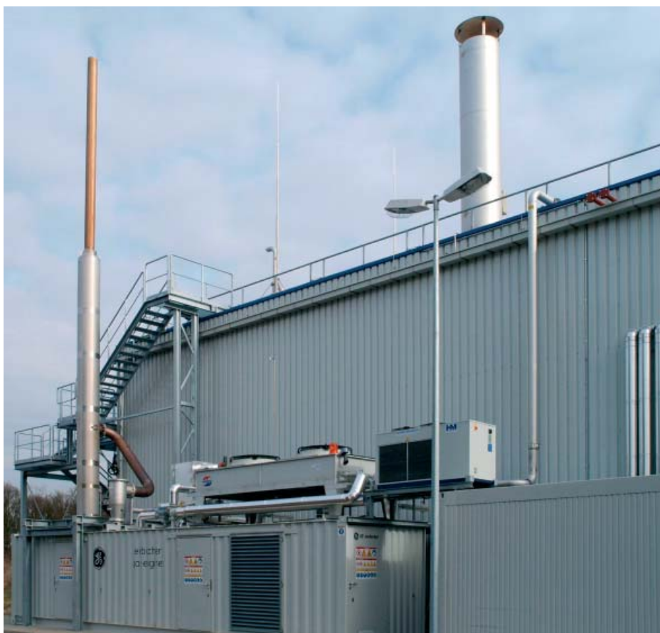
Blockheizkraftwerk der Vergärungsanlage zur Erzeugung von jährlich 4,5 Millionen Kilowattstunden Strom und 800.000 Kilowattstunden Wärme aus Biogas (Quelle: MM Video Fotowerbung)
