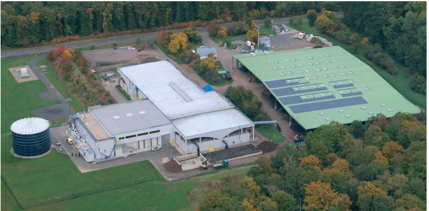
Humus- und Erdenwerk Ilbenstadt, im Vordergrund die Erweiterung um eine Vergärungsstufe (Quelle: MM Video Fotowerbung)
